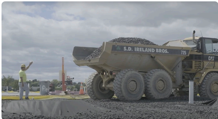
Mise en place du géotextile et du Gravel
