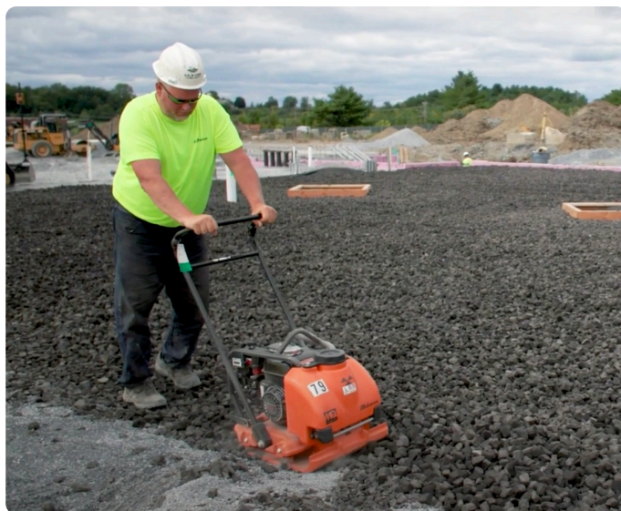
Compactage par plaque vibrante
