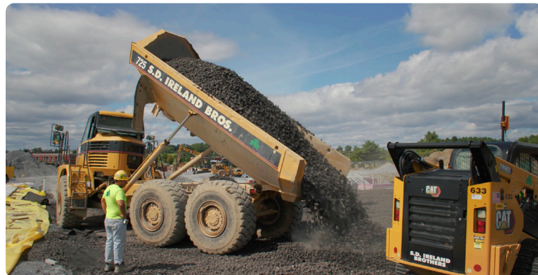
Mise en place du géotextile et du Gravel
