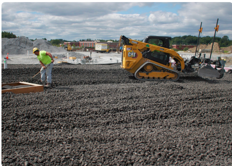
Compactage par engin à chenilles
